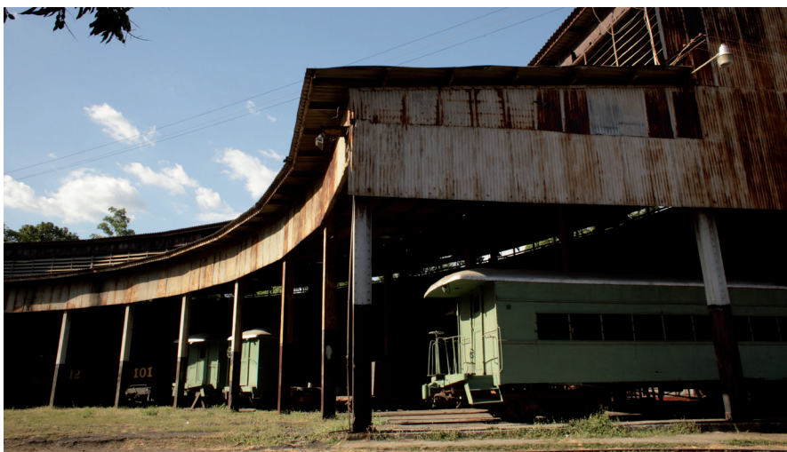
Hangar circular de locomotoras, estación FENADESAL, San Salvador (IRCA, ca. 1915) Fotografía de Óscar Leiva (2012), propiedad de Fundación AccesArte
